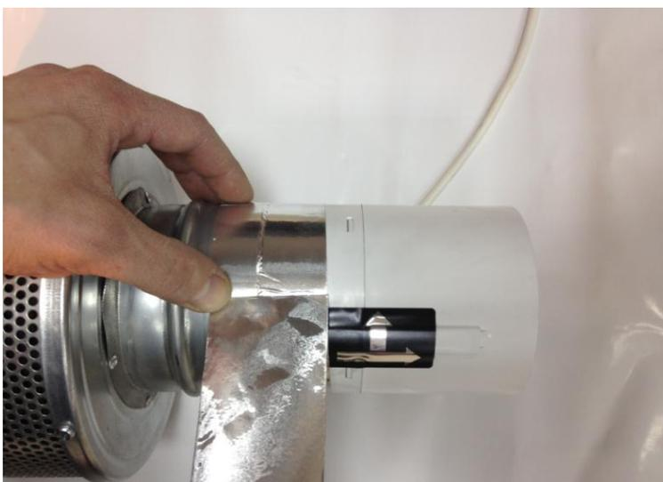
Подсоединяем переходник. Он служит для надежного соединения гофры
