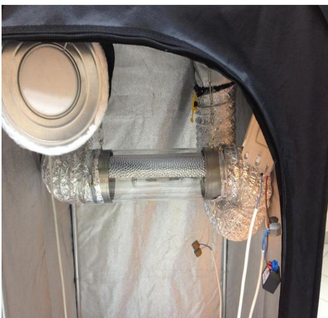
Для удобства фиксируем удлинитель и остальную коммутацию внутри тента пластиковыми стяжками.
