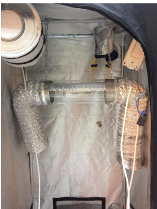
Соединяем левую часть гофры с переходником и проклеиваем соединение алюминиевым скотчем
